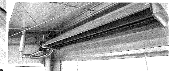
Die Profi-Lösung mit hohem Installationsaufwand: ein mit Erdgas betriebener Dunkelstrahler mit Abgaskamin unter der Hallendecke
